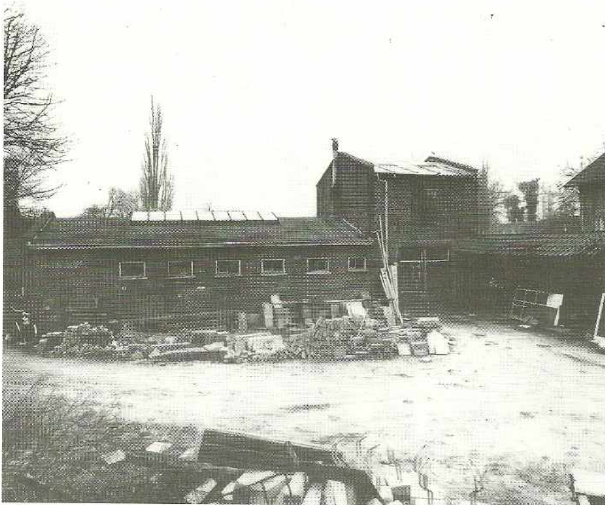
De oude badinrichting diende tot de sloop in de zestiger jaren als werkplaats van gemeentewerken. In het hoge gedeelte midden bevond zich het kerkelijk bad.
